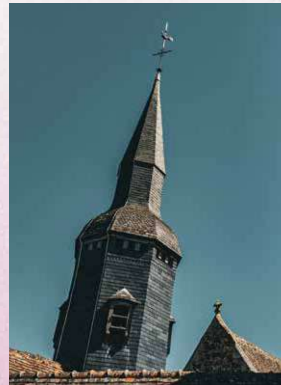
Installation d'un paratonnerre sur le clocher
