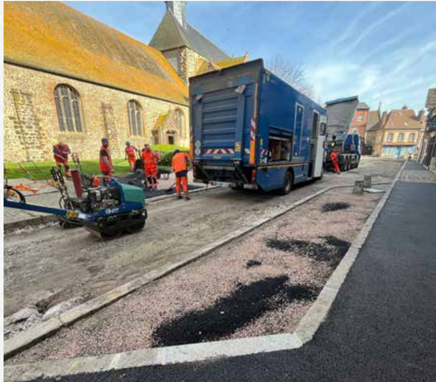
Exemple de réfection de voirie et de trottoir à Verneuil-d'Avre-et-d'Iton
