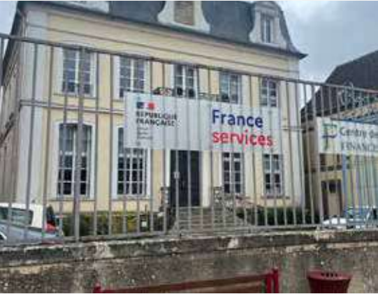
Le France services de Verneuil est désormais accessible aux PMR
