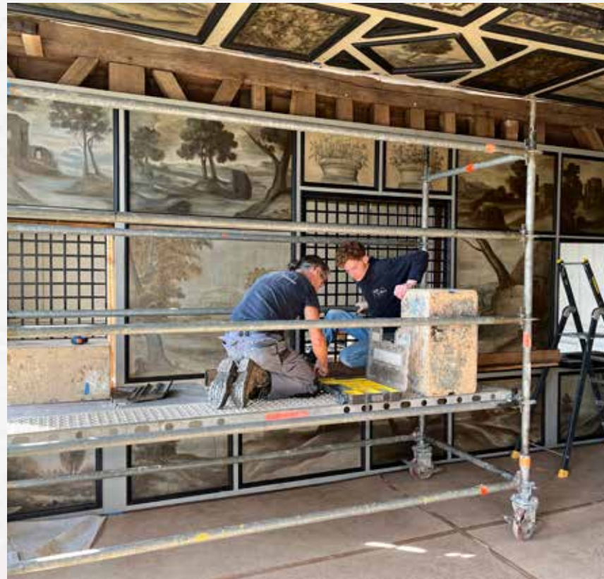
Rénovation du parloir de l'abbesse
